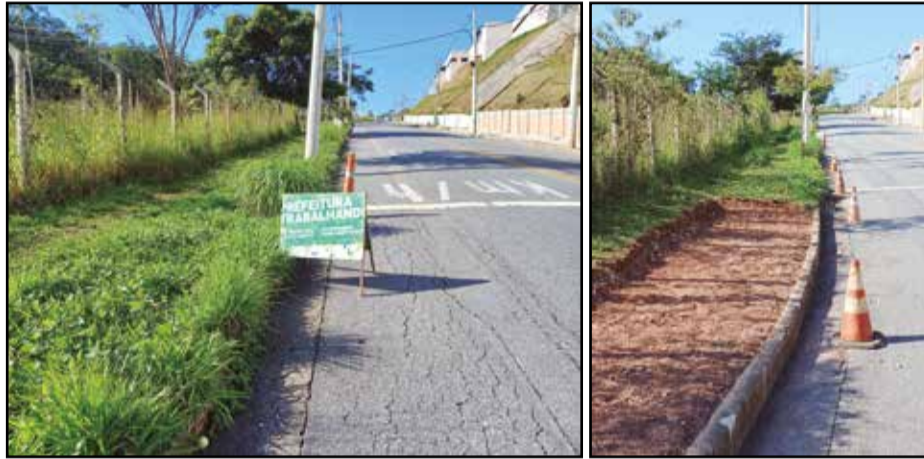
Já está em execução a construção de passeio ao lado da área verde da Rua Rubens Caporali Ribeiro, fruto de emenda impositiva do vereador BRAULIO LARA no valor de R$ 100 mil
